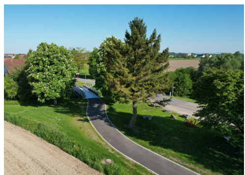
Aménagement d'une voie verte cyclable entre Gambsheim et la route départementale 502.
