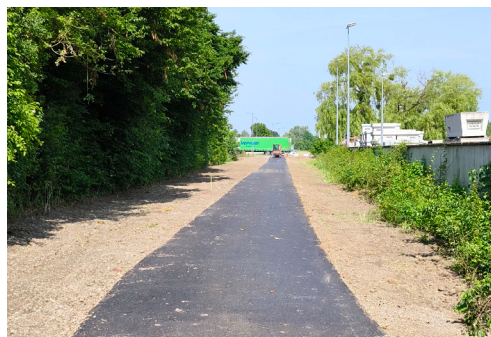
Aménagement d'une voie verte cyclable. Mise en service juin 2025.
