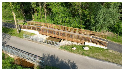
Aménagement d'une voie verte cyclable, complétée par une passerelle bois métal. Mise en service juillet 2024.
