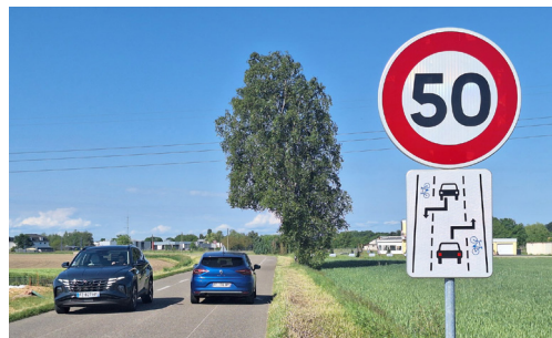
Liaison Gambsheim-Offendorf en CVCB "Chaussée à Voie Centrale Banalisée" permettant de partager la route entre les voitures et les vélos. Mise en service septembre 2023.
