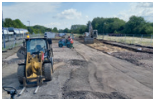
Travaux à la Gare de Roeschwoog
