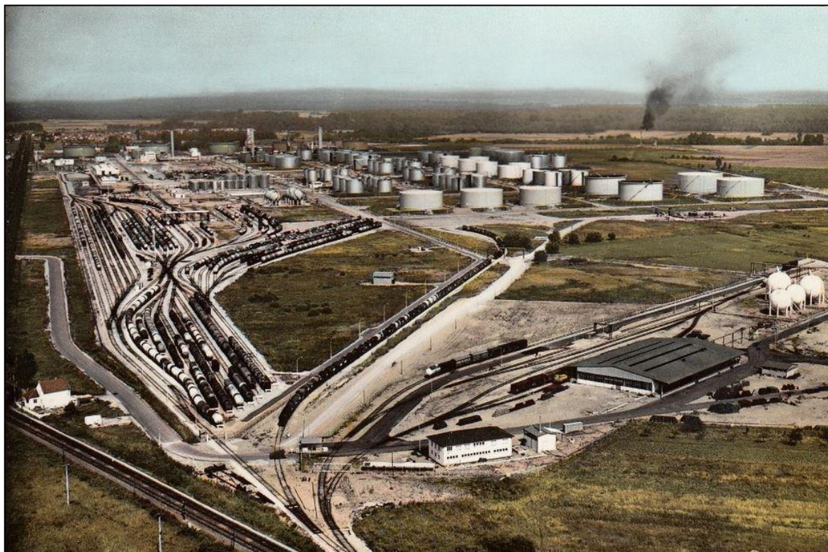
Fig. 2. Vue historique de Rhône Gaz (au premier plan) et de la raffinerie depuis le Sud-Ouest
