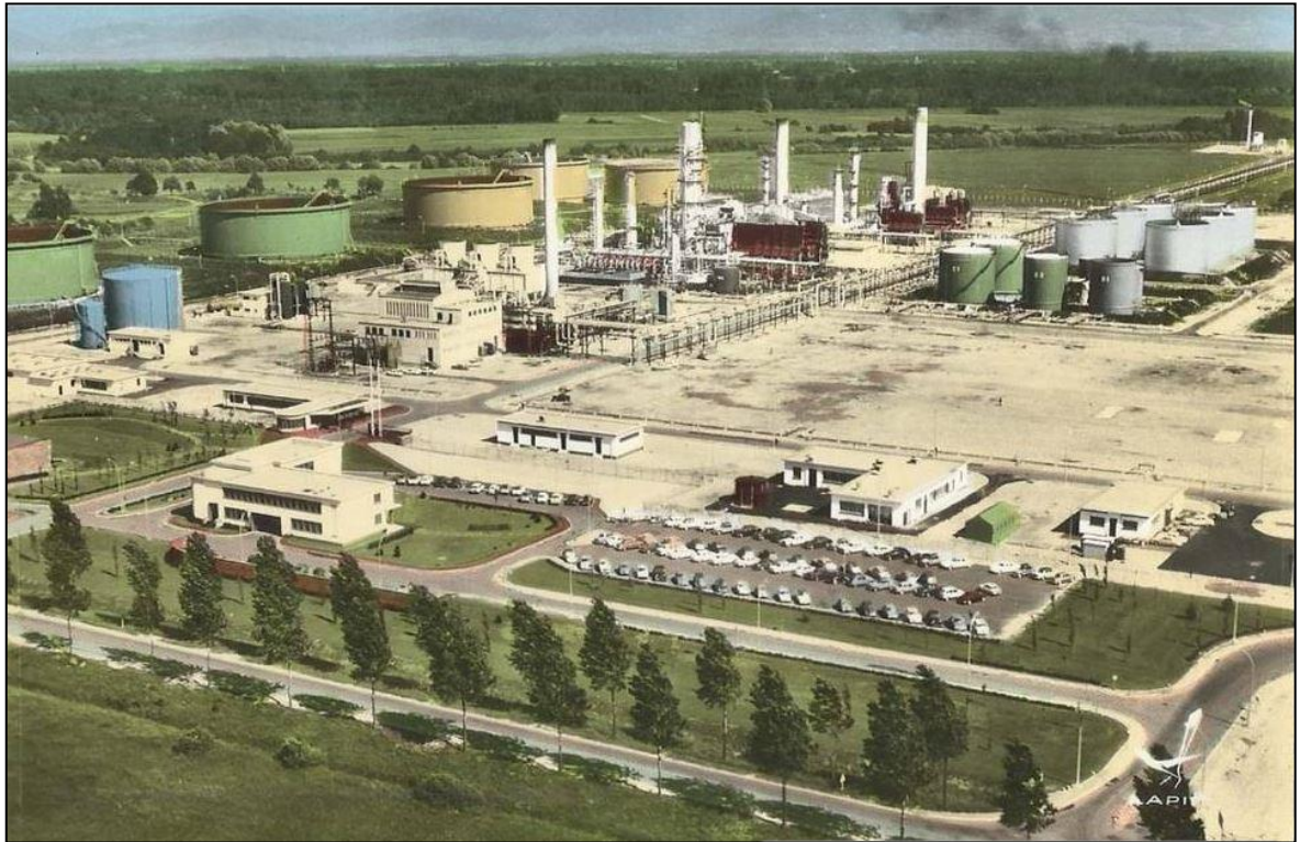
Fig. 3. Vue historique de la raffinerie depuis le Nord-Ouest (RD468 au premier plan)
