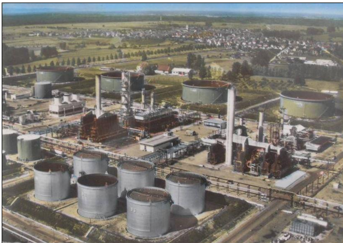
Fig. 5. Vue historique de la raffinerie depuis le Sud (au fond : ville de Drusenheim)
