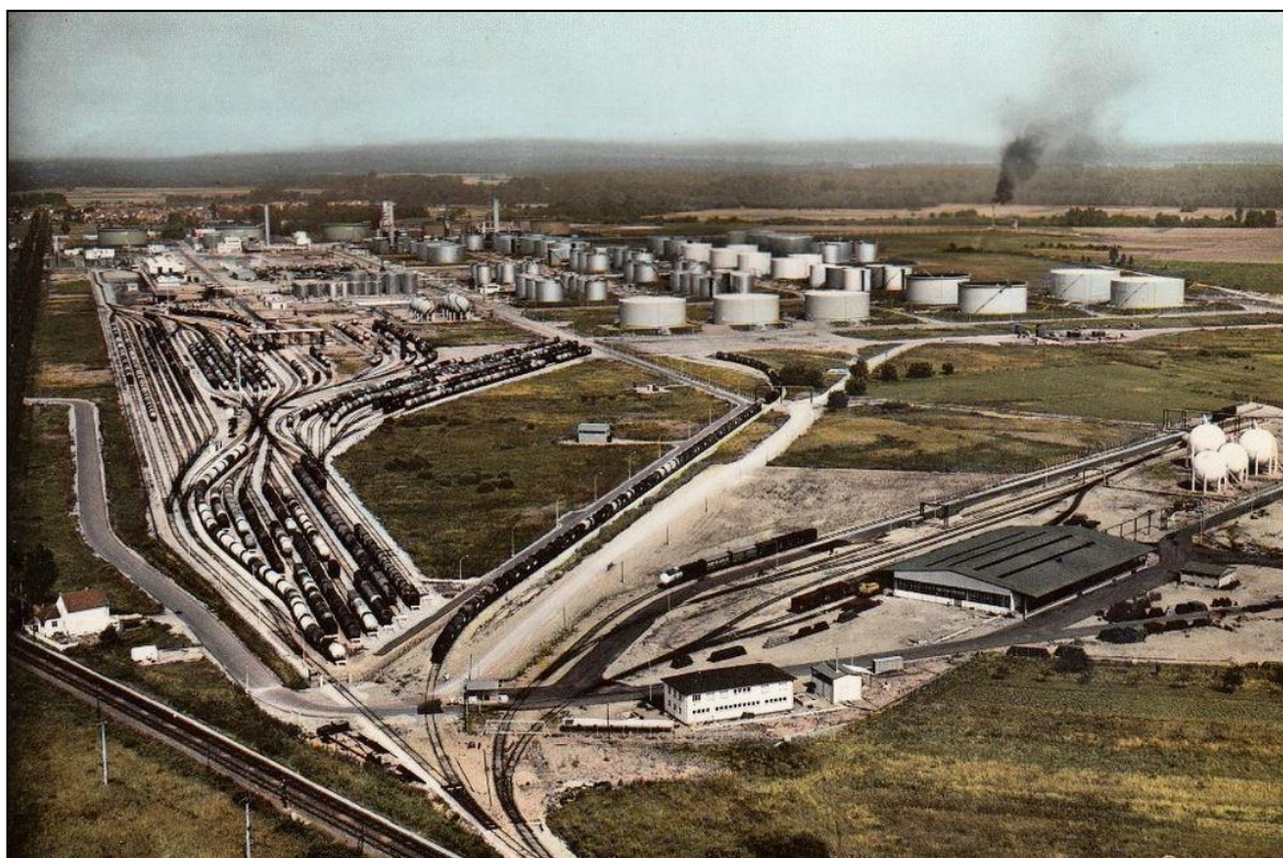
Fig. 3. Vue historique de Rhône Gaz (au premier plan) et de la raffinerie depuis le Sud-Ouest
