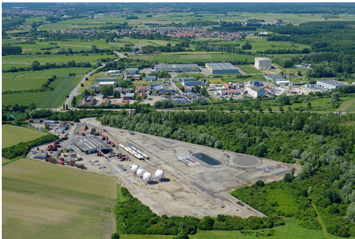
Photographie 4 : Site de l'entreprise Rhône Gaz à Herrlisheim concerné par un PPRT
