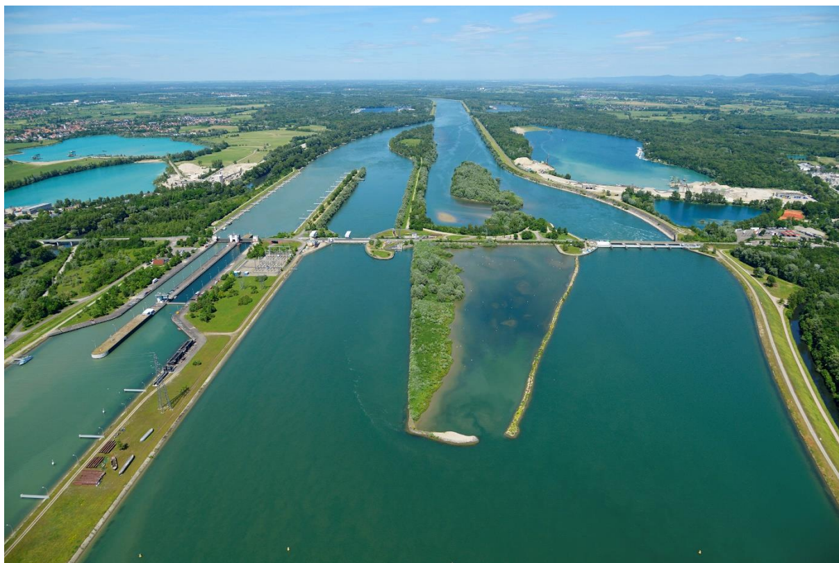
Photographie 7 : Barrage hydroélectrique sur le Rhin, à Gamsheim
